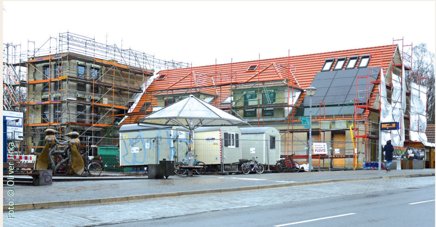
Derzeit etwas desolat erscheinend - der Kulturbahnhof ist noch immer eine Baustelle.
