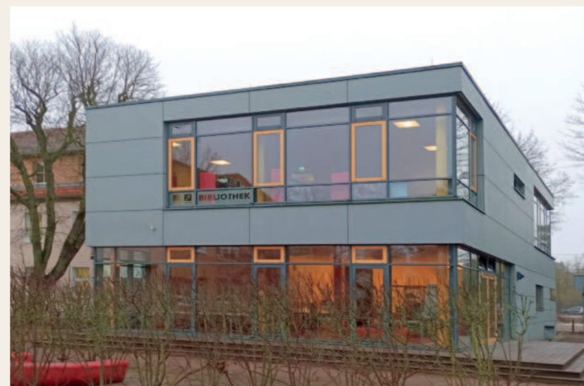
Die Ahorn Grundschule in Bergfelde bekommt eine neue Sporthalle und neue Räume
