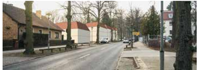
Blick von der Hauptstraße
