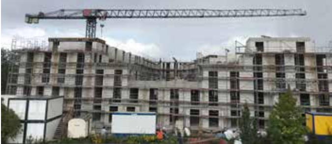
Monsterbaustelle zwischen Schule und Einkaufszentrum – Der Blick vom Plattenbau.
